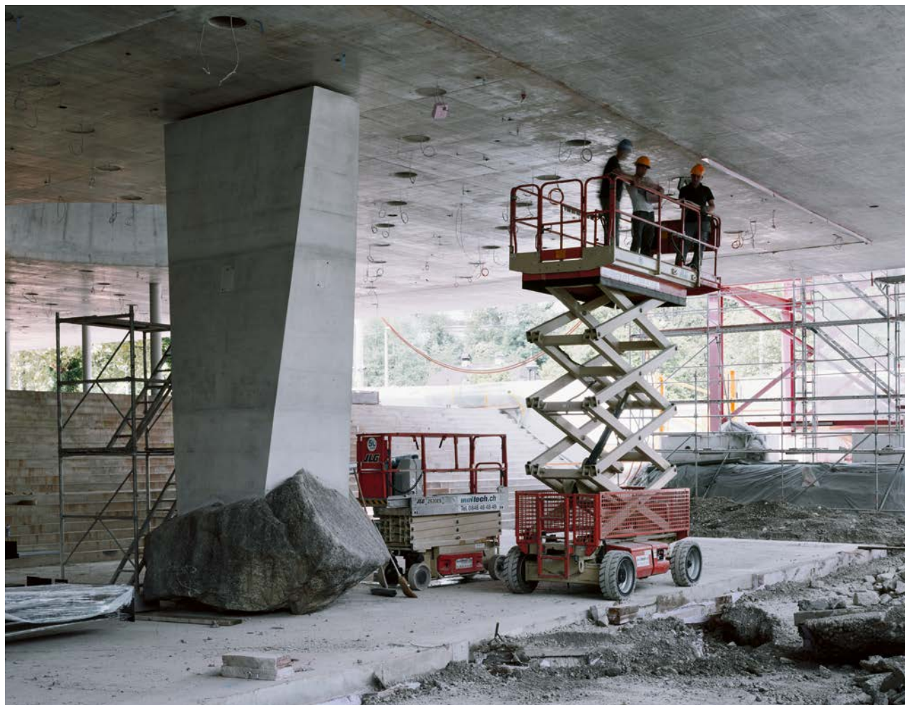
Skulpturale Pendelstütze im Foyer: Der «Findling» des Künstlers Eric Hattan betont die Stütze als statisches Punktlager des Dachs. Während des Rohbaus war das statische System als Pendelstütze deutlich sichtbar.
