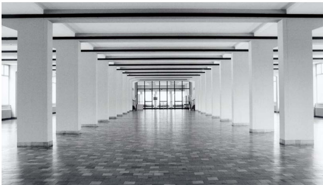
Zwischen 1958 und 2018 trennte ein Zwischenboden den oberen Bereich der Ausstellungshalle ab, um mehr Fläche für Präsentationen bieten zu können.
