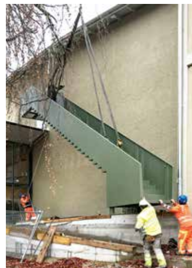
Montage der neuen Fluchttreppe für den Theatersaal.
