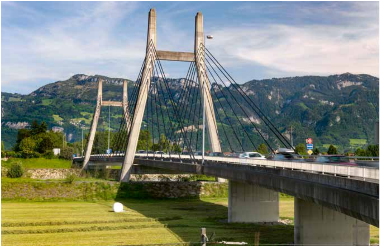
Schrägseilbrücke Diepoldsau SG – neu war es, eine Schrägseilbrücke als Strassenbrücke einzusetzen. Ausschlaggebend für den Wettbewerbsgewinn waren die Gestaltung, der wirtschaftliche Materialeinsatz und ein optimierter Bauvorgang.
