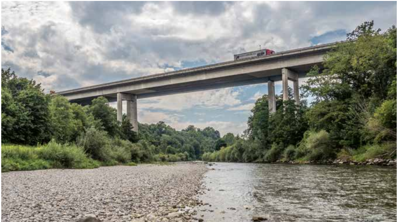
Das zürcherische Weinland zwischen Winterthur und Schaffhausen ist landschaftlich durch eine sanfte Hügel- und Kulturlandschaft geprägt. Zwischen Kleinandelfingen und Andelfingen überquert die 1958 eröffnete Weinlandbrücke die Thur als feingliedriges Brückentragwerk – ein damals ungewöhnlich schlankes Bild, weil der Einsatz von Spannbeton neu war.
