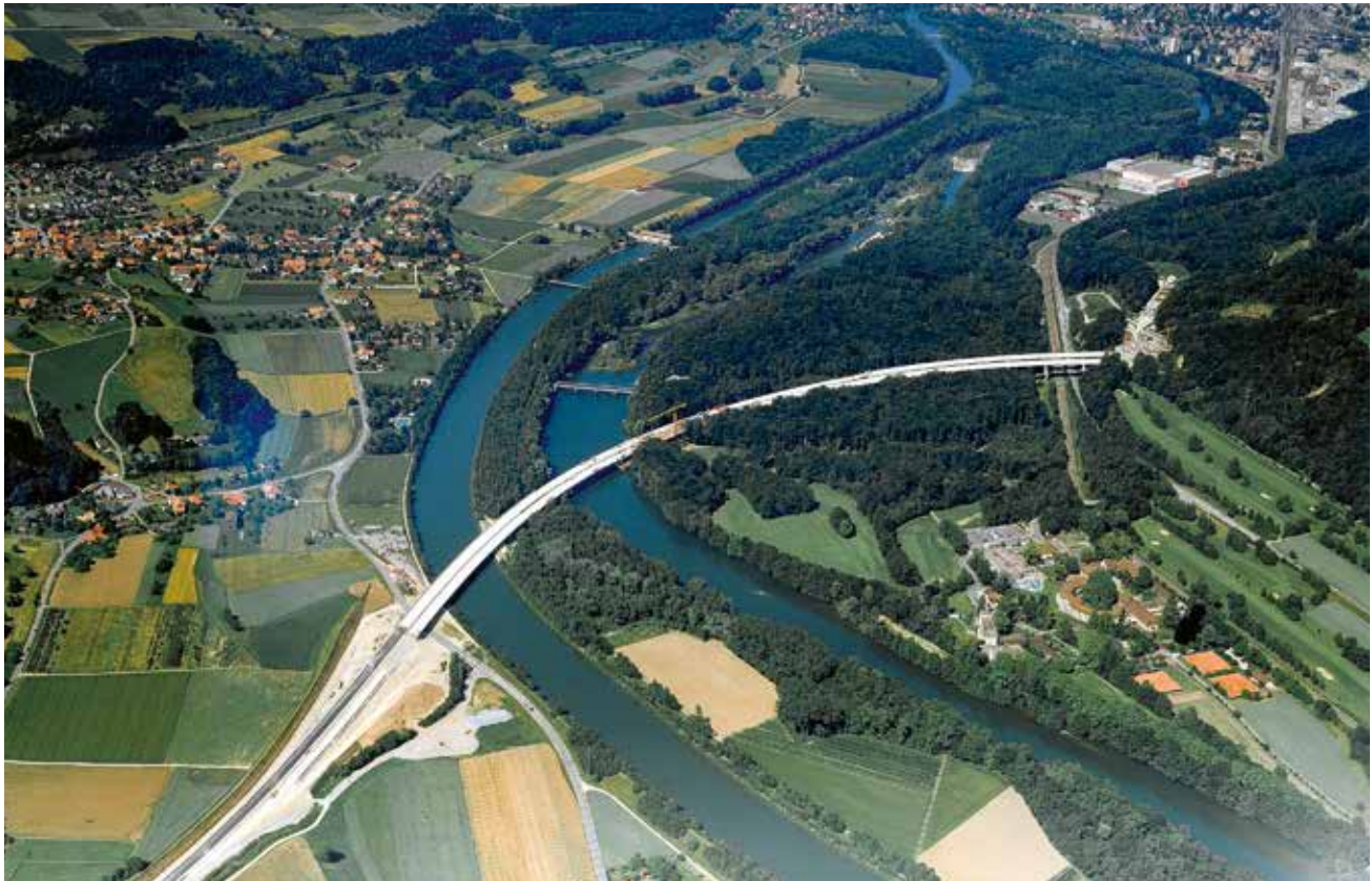
Das Aareviadukt bei Schinznach AG führt in einem sanften Bogen über den Fluss und den Oberwasserkanal.
