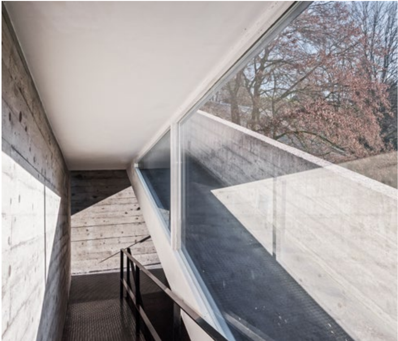
Die betonierte Rampe führt auf der Nordfassade des Baus vom Erdgeschoss zur Dachterrasse. Sie bildet ebenso ein funktionales wie auch ein dokumentarisches Scharnier: als Erschliessung und Verankerung am Ort und als Hinweis auf die ursprünglich geplante Materialisierung der Kuben.
