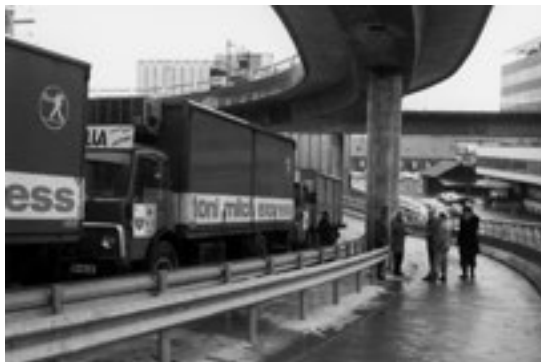
Nachdem die Rampe erstellt war, führte die Empa am 21. Januar 1975 Belastungsversuche durch.
