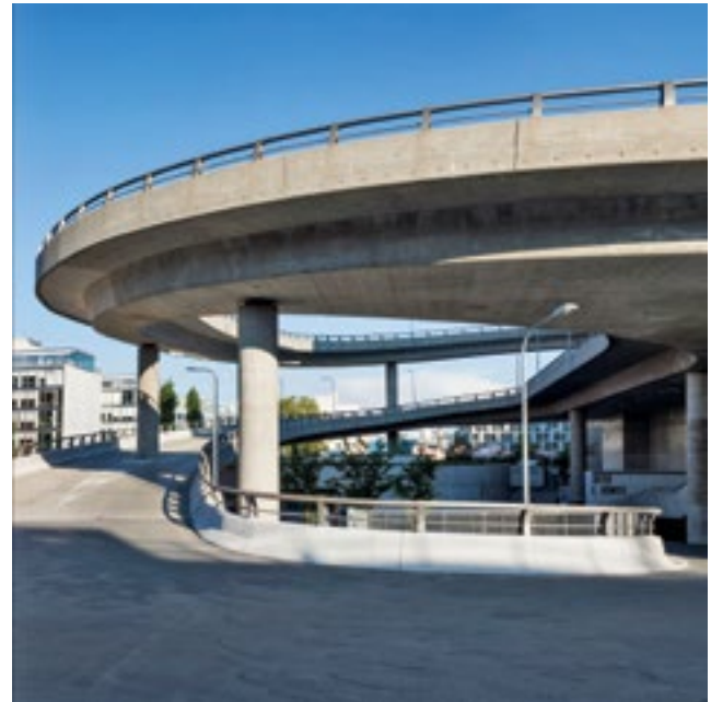
Die Rampe dient als Aufenthaltszone und Zugang für die Besucher der Konzertsäle und des Kinos. Als Fluchtweg darf sie wegen der zu grossen Steigung nicht dienen.
