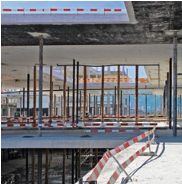
Die Toni-Molkerei wurde 2011 bis auf ihren Rohbau rückgebaut, dieser wurde dann stark angepasst. Die Voraussetzungen dafür waren von Beginn an eingeplant worden.
