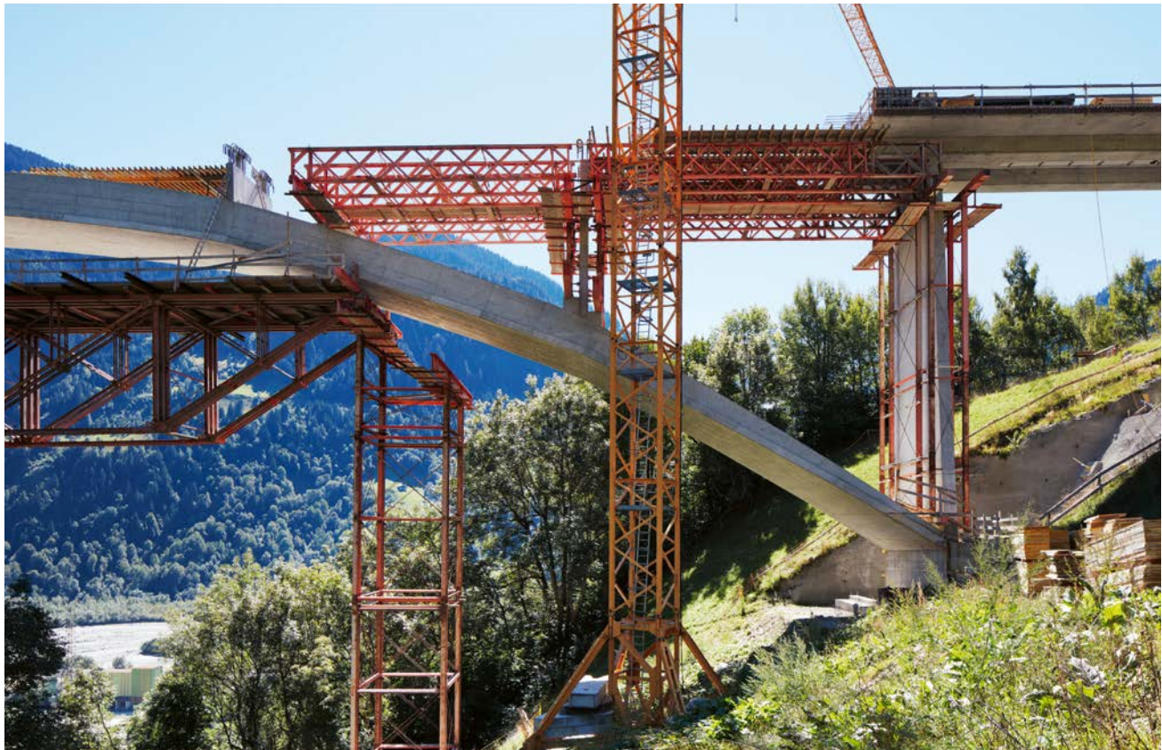
Bauphase der Bogenbrücke mit einfachen Gerüsttürmen und einem verbindenden Fachwerkträger.
