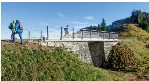
Die Brücke Schild besteht aus tragenden Betonplatten, die auf historischen genieteten Eisenträgern aufliegen.
