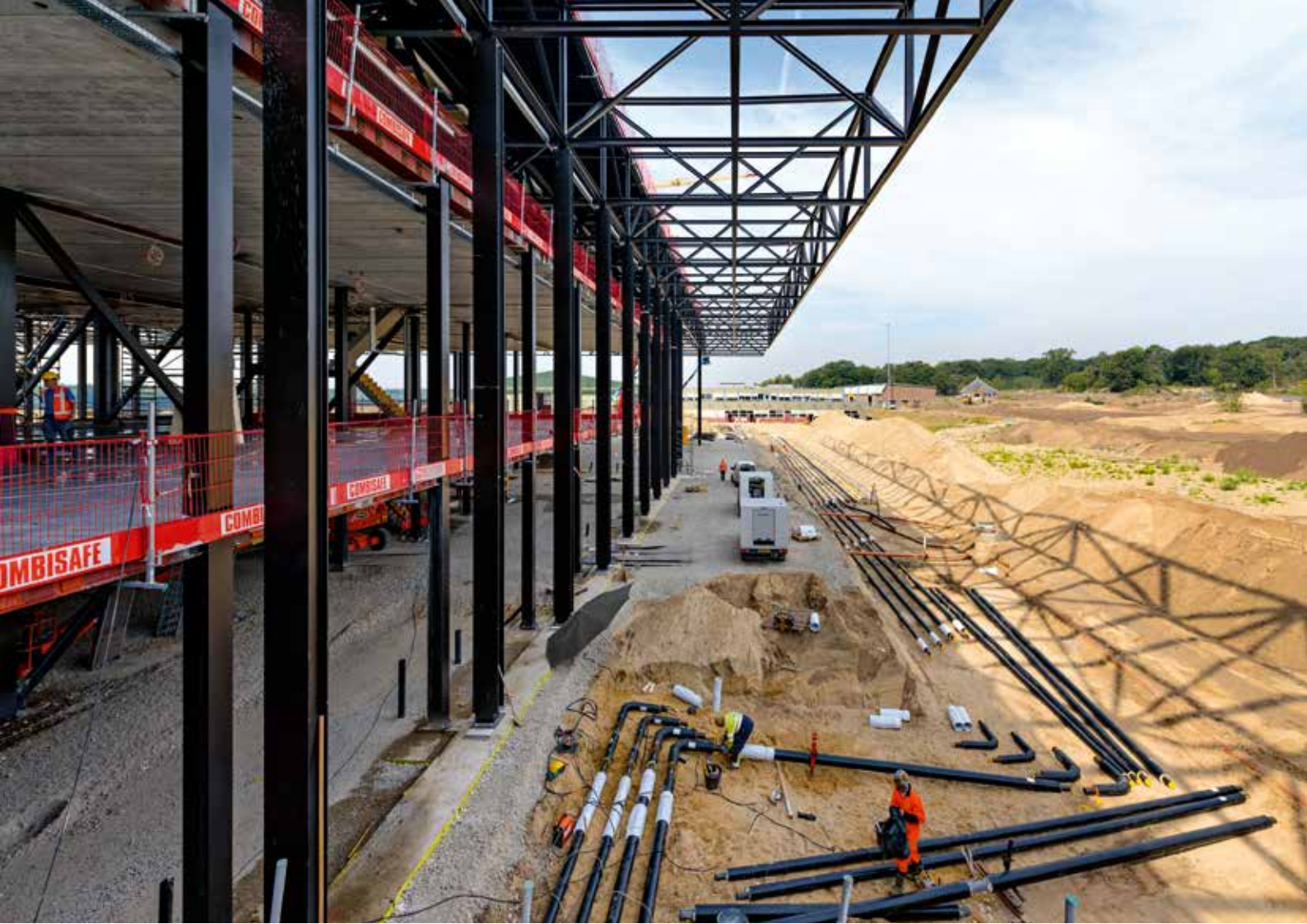
Baustelle des Stahlbaus in der sandigen Landschaft des vormaligen Militärflugplatzes Soesterberg.
