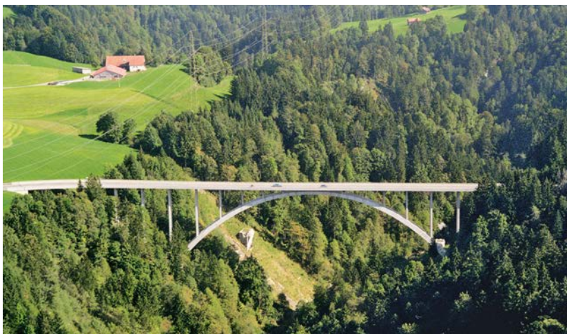
Die Hundwilertobelbrücke zwischen Hundwil und Waldstatt im Kanton Appenzell Ausserrhoden. Die Brücke ist 90 m hoch und 269 m lang und hat eine Spannweite von 143 m. Beim Bau wurde ein neues Verfahren angewendet.
