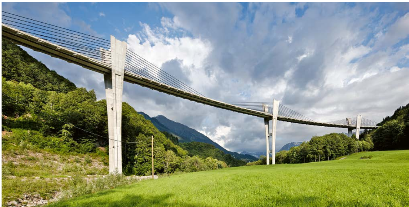
Die von Christian Menn entworfene Sunnibergbrücke wurde zum Wahrzeichen der Gemeinde Klosters-Serneus und 2001 mit dem «Outstanding Structure Award» der IABSE ausgezeichnet.
