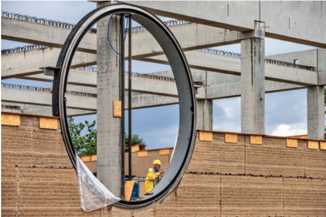
Das Kräuterzentrum von Ricola in Laufen – wie es in den Medien praktisch nie zu sehen ist: Der Lehm aufgestapelt in einzelnen vorgefertigten Blöcken, dazwischen der runde Stahlrahmen für das Fenster mit den beidseits angeordneten Stahllaschen und dahinter das Betonskelett, das das ganze Bauwerk stabilisiert und trägt.
